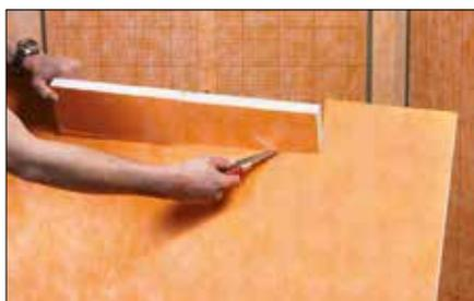
I pannelli pendenziati possono essere tagliati facilmente su misura con un semplice cutter seguendo linee di taglio pre-incise sul retro. Per facilitare lo stoccaggio e il trasporto in cantiere, i pannelli sono piegati in due parti e tenuti insieme dalla guaina impermeabilizzante Schlüter-KERDI già incollata. I pannelli possono essere utilizzati per scarichi orizzontali e per scarichi verticali. I diversi modelli e le possibili modalità di installazione vengono mostrate di seguito.
