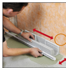
rif. 1. allineare il supporto canalina
