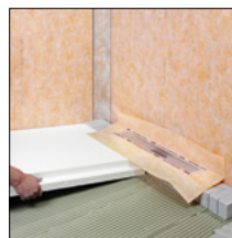
rif. 3. posizionare il pannello di livellamento
