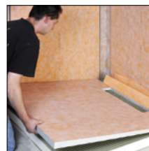
rif. 3. posizionare il pannello pendenzato
