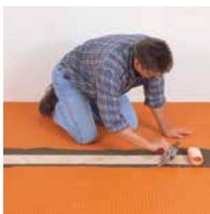
4. Nelle zone di giunzione della guaina **Schlüter®-DITRA 25** è necessario utilizzare il collante **Schlüter®-KERDI-COLL-L** immergendo completamente nella colla le fascette impermeabilizzanti **Schlüter®-KERDI** di 12,5/15 cm. La fascetta deve sormontare di almeno 5 cm la guaina da entrambe le parti.
