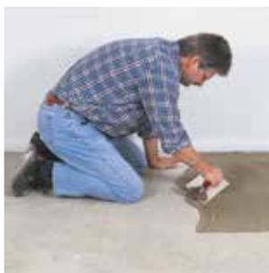
1. La colla viene applicata con una spatola dentata sul sottofondo.
