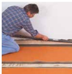
6. Per la realizzazione di giunti di dilatazione tra pavimento e parete si consiglia l'impiego dei profili **Schlüter®-DILEX**, che non necessitano di manutenzione.
